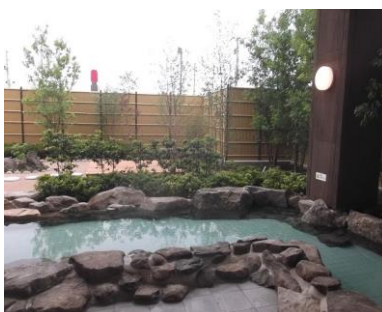
公共温泉施設 造園工事
