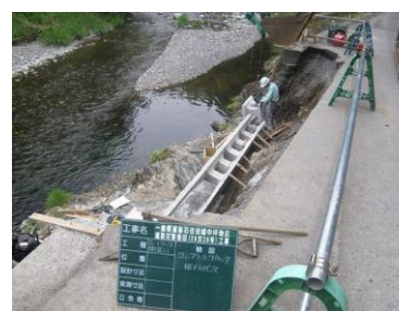
道路改良工事
