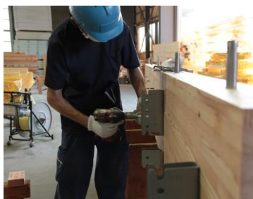
金物取付の作業
