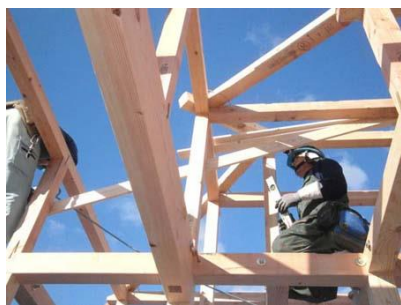
現場大工の様子
