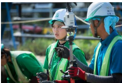
道路改良工事
