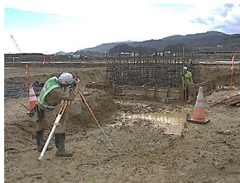
農地災害復旧事業工事
