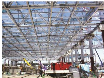
工場建屋 梁・柱
