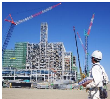
建築工事現場
