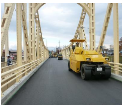
舗装工事現場
