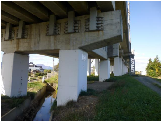
東北新幹線の橋脚部分
