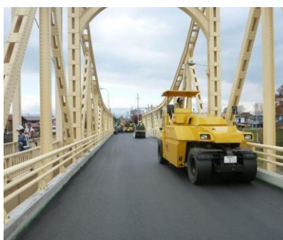
舗装工事現場
