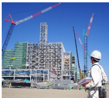
建築工事現場
