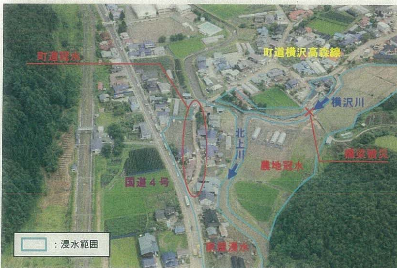
岩手町横沢地区の被災状況①
