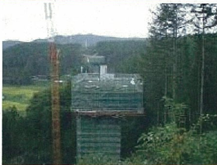
付替国道3号橋 少しずつ橋を延ばしていきます
