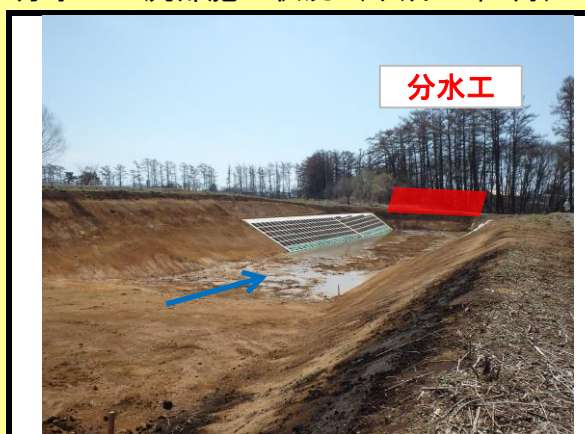
分水工上流部施工状況（平成29年4月）
