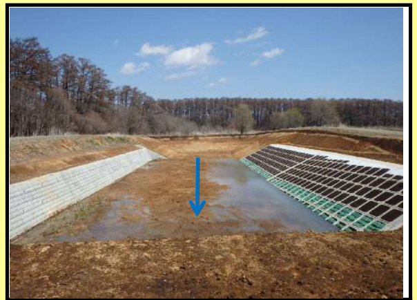
分土工上流部施工状況（平成29年4月現在）
