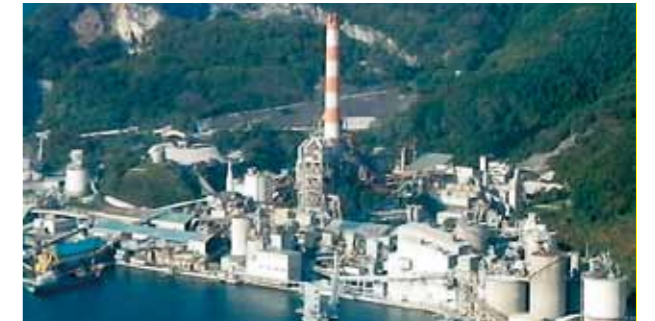
太平洋セメント株式会社大船渡工場
