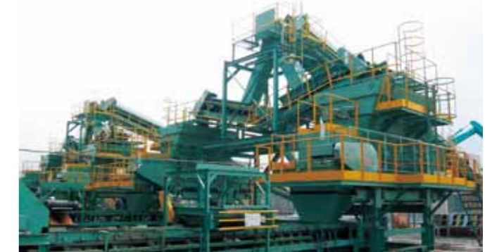
陸前高田市の土壌分級処理施設（リマテックJV）
