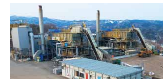
仮設焼却炉（宮古市）
