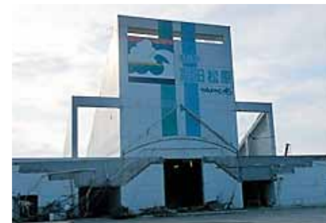
震災遺構（津波により壊滅的な被害を受けた「道の駅高田松原」）
