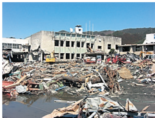
津波により壊滅した大槌町役場
