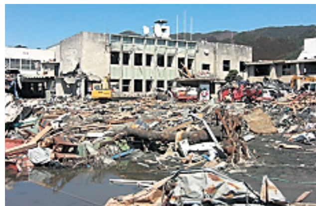
津波により壊滅した大槌町役場
