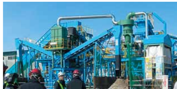
宮古市に設置した破碎・選別ライン（鹿島JV）
