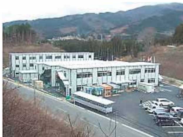
現在の陸前高田市の仮設庁舎
