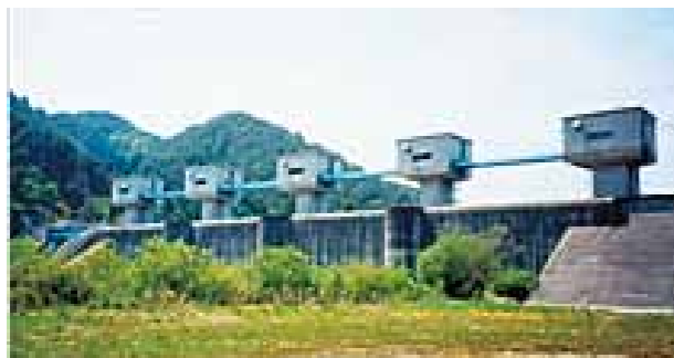
普代水門の全景
