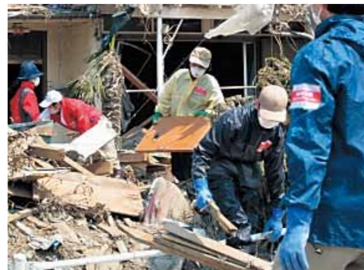
東日本大震災津波の被災地で がれきを撤去するボランティア
