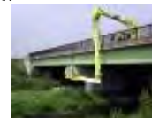
橋梁点検車を使った橋梁点検
