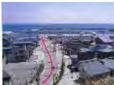
漁港から高台への避難路の整備
