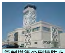
管制塔等の倒壊防止
