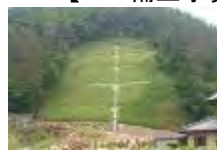
崩壊地(発生源)の復旧・予防
