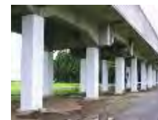
高架橋の補強
