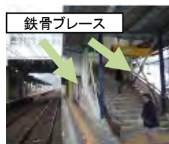
橋上駅の補強
