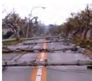
電柱の倒壊による 道路閉塞
