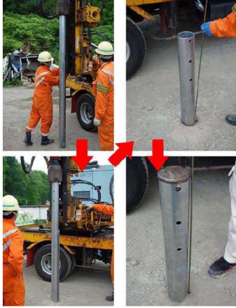
施工・測定試験状況
