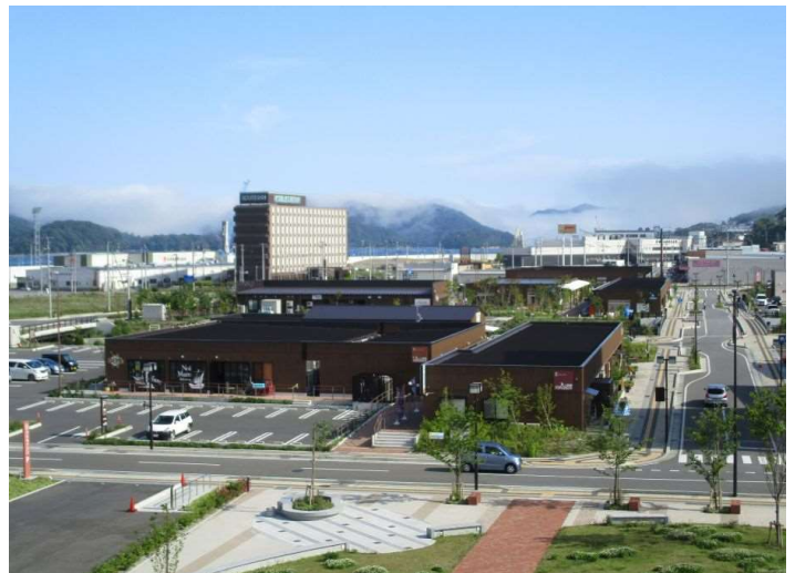
【一団地の津波防災拠点市街地形成施設（大船渡市）】
