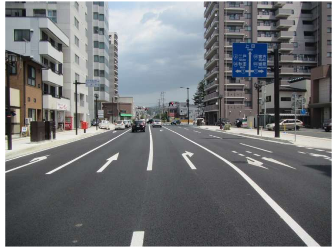
【都市計画道路盛岡駅長田町線（盛岡市）】
