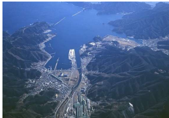
【臨港地区（釜石市）】
