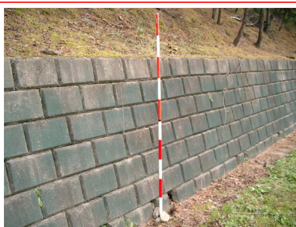
ブロック積擁壁（ブロック布積み）
