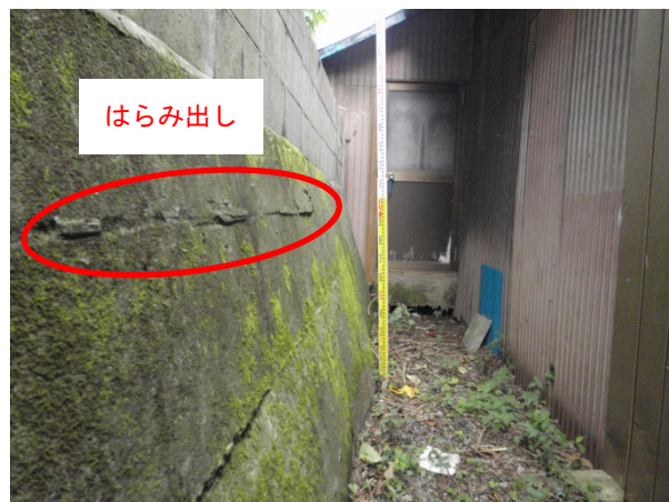
明らかな変状がある対策施設（要協議）
