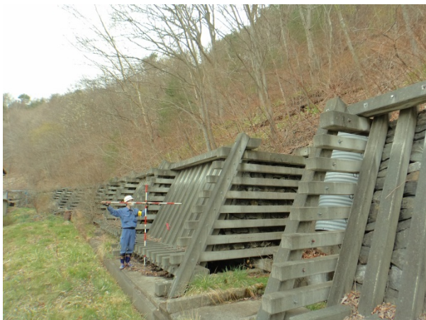
井桁擁壁工
