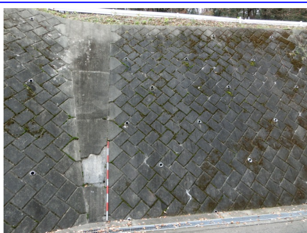
ブロック積擁壁（ブロック谷積み）
