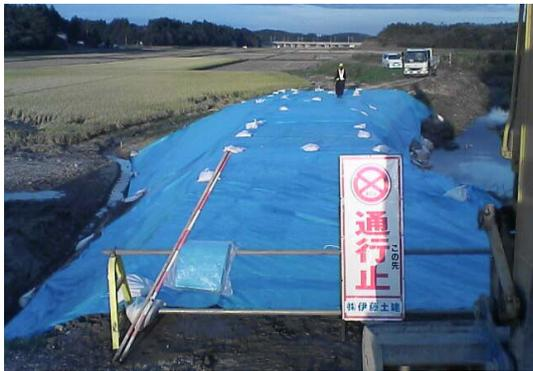
堤防補修の様子(照越川)
