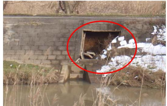
護岸の損傷(荒川)
