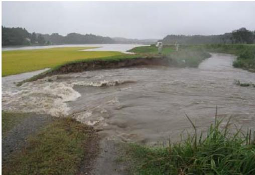
照越川破堤状況(栗原市築館照越地内)
