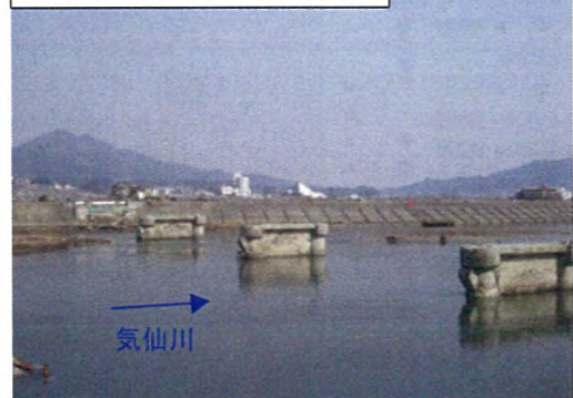
④ 市道 姉齒橋 上部工流失
