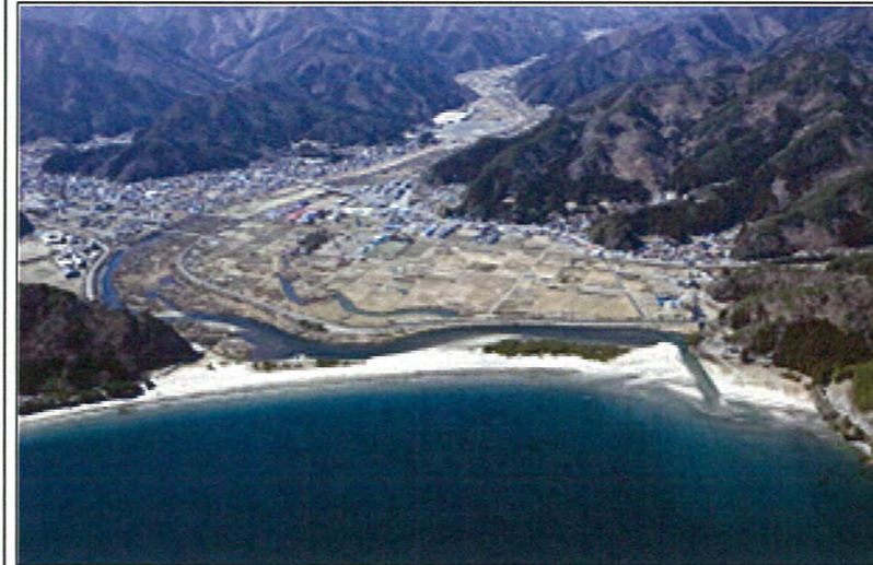
被災前状況 H22.3.19 撮影
