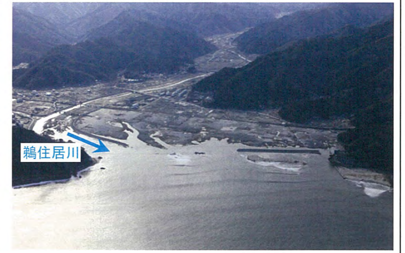
被災後状況 H23.3.28 撮影
