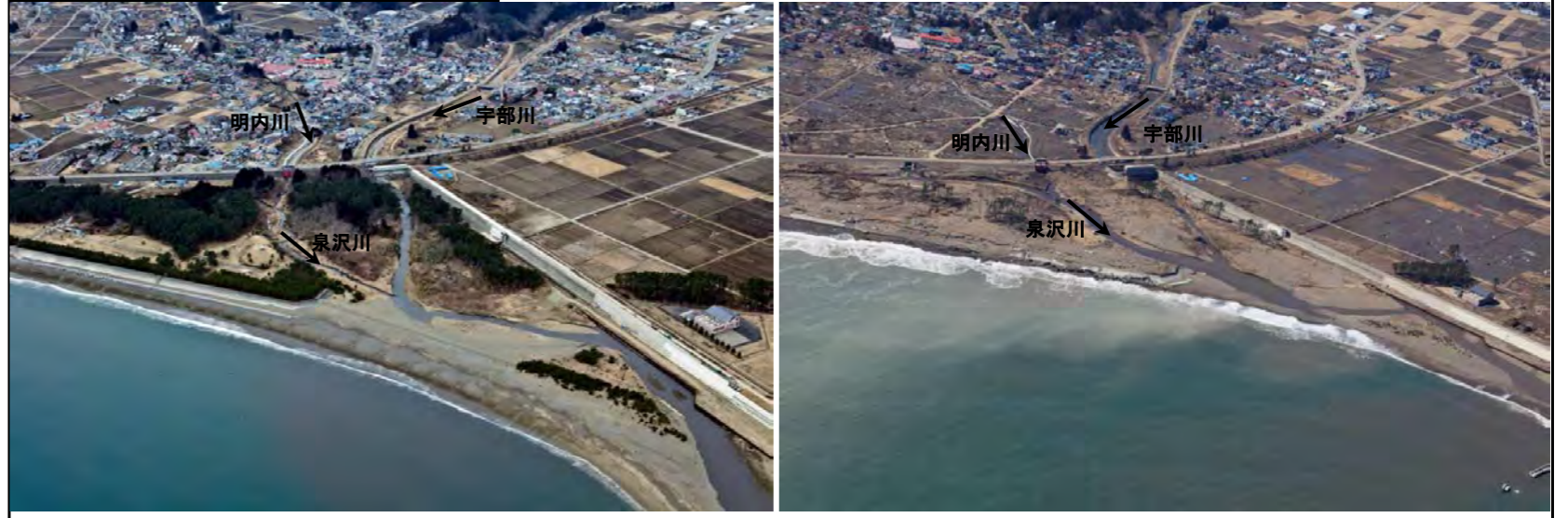
被災前状況 H22.3.9 撮影
