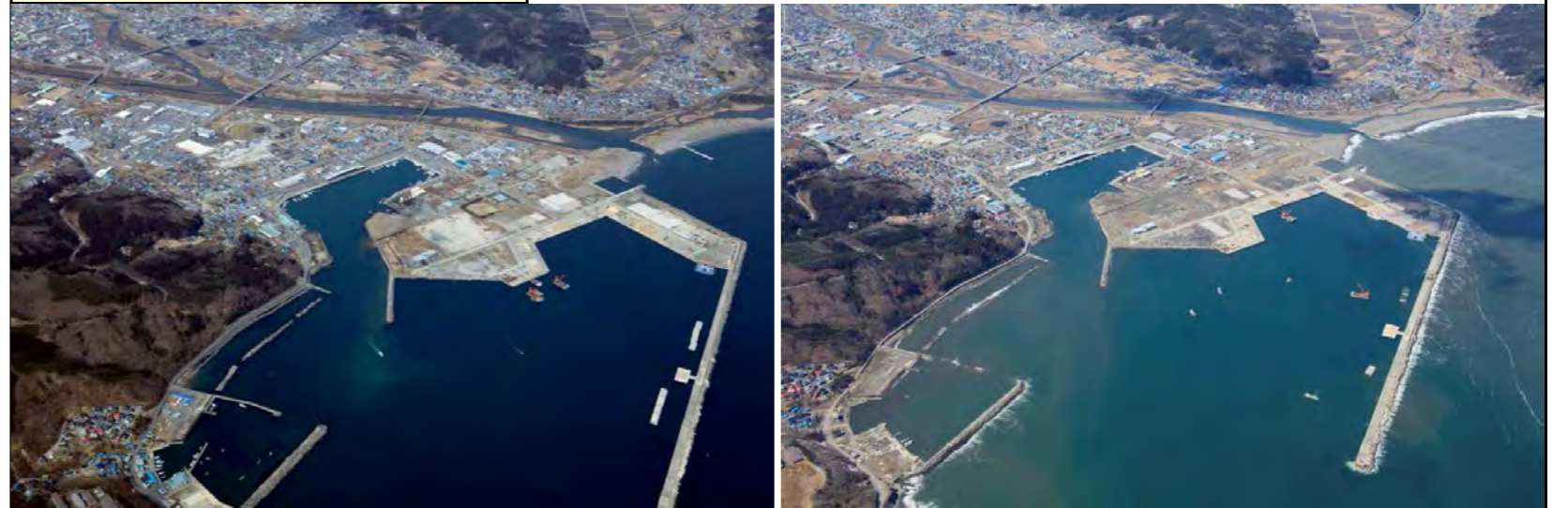
被災前状況 H22.3.24 撮影
