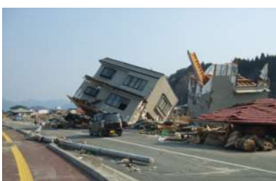
関口川 下流部右岸状況
