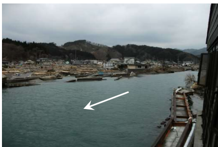
関口川 下流部破堤状況
