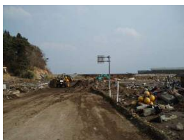
道路の被災状況
