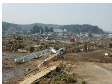
水門背後地の被災状況
