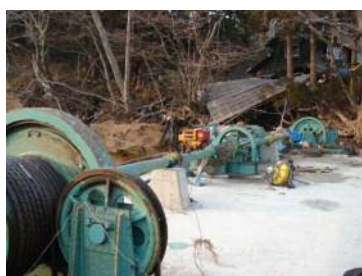
水門上屋の被災状況
