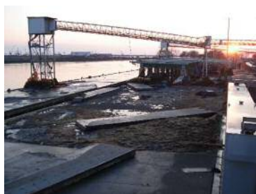
久慈港諏訪下地区（製氷工場付近）
