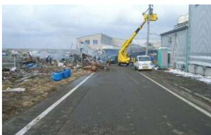
八木港線の被災状況
