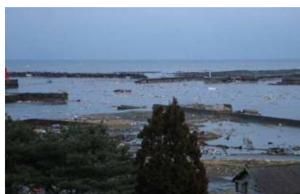
八木港の被災状況
