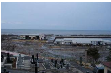
八木港の被災状況
