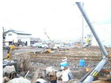
八木港の被災状況
