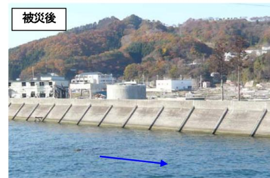
既存の河川堤防の法面には縦のリブが付いており、のっぺりとしたコンクリート表面に表情を与えている。
