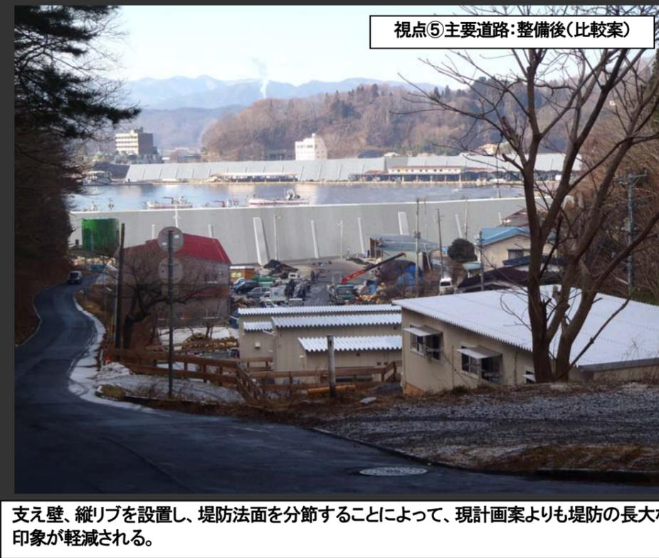
支え壁、縦リブを設置し、堤防法面を分節することによって、現計画案よりも堤防の長大な印象が軽減される。
