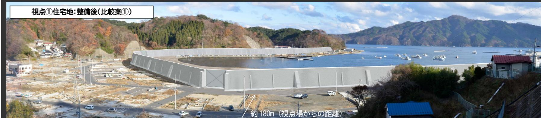
支え壁、縦リブを設置し、堤防法面を分節することによって、現計画案よりも堤防の長大な印象が軽減される。
