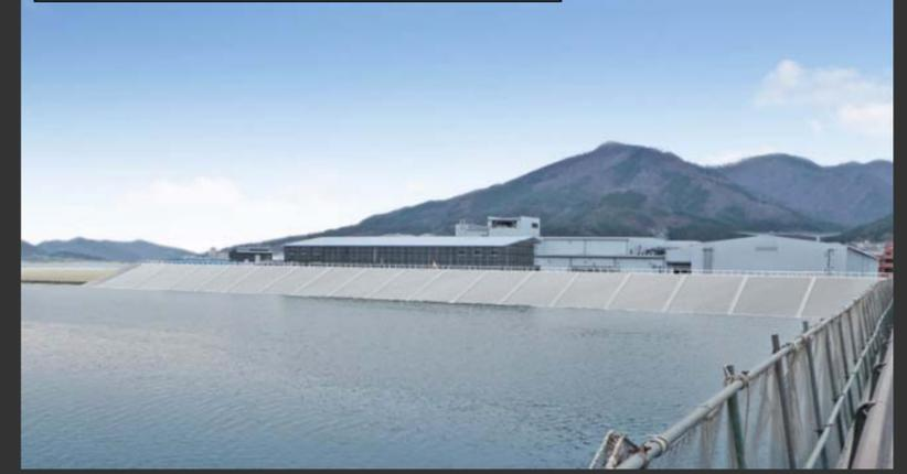
縦リブによって、コンクリート面にリズム感が生まれ人工的で長大な印象が軽減される。
