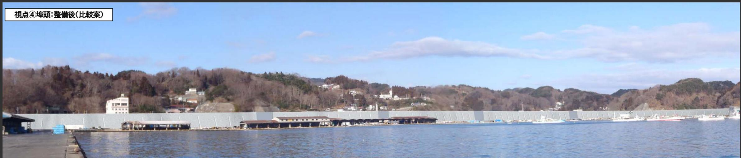
縦リブを設置することで堤防法面が分節され、現計案よりも堤防の長大な印象が軽減される。
