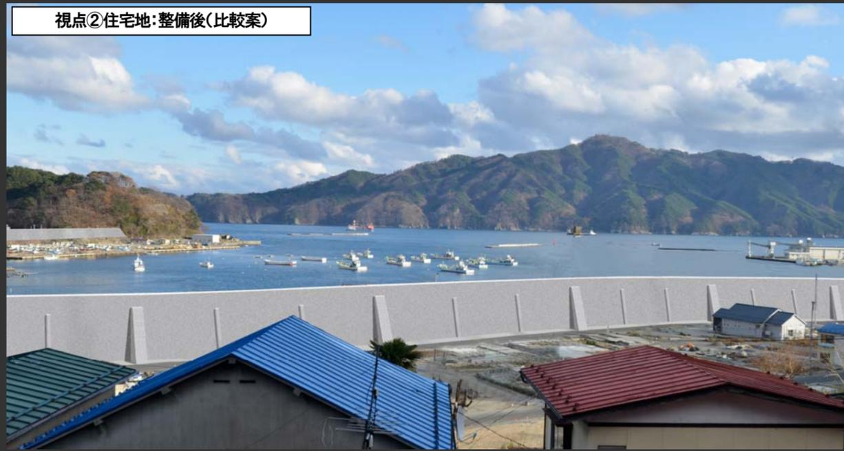
縦リブ、支え壁を設置し、堤防法面を分節することによって、堤防の長大な印象が軽減される。
