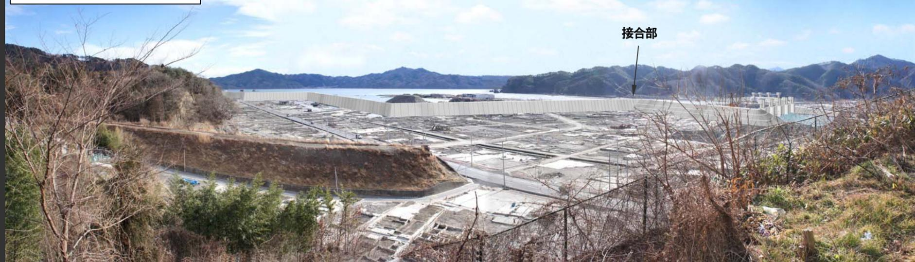
異なる構造の堤防の接合部があり、折れ曲がった線形で整備されるため、煩雑な印象の景観となる。水門の上屋が目立ち不安定な印象を与える。
