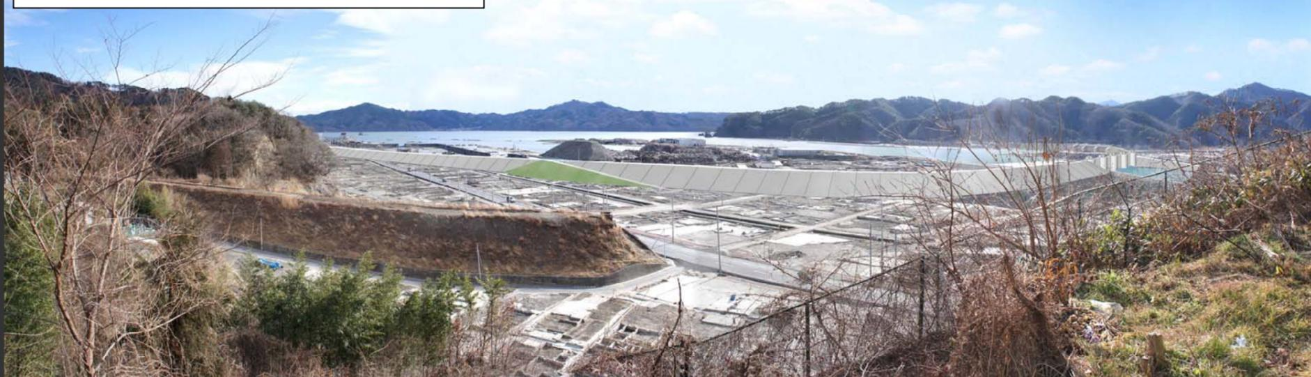
傾斜堤が地形に収まり曲線的に整備され、すっきりとした景観となる。水門の上屋の突出した不安定な印象が軽減し、水門と堤防が一体的に調和とした印象となる。坂路部分を芝で被覆することにより、長大なコンクリート法面の見えの分節を図ることができる。
