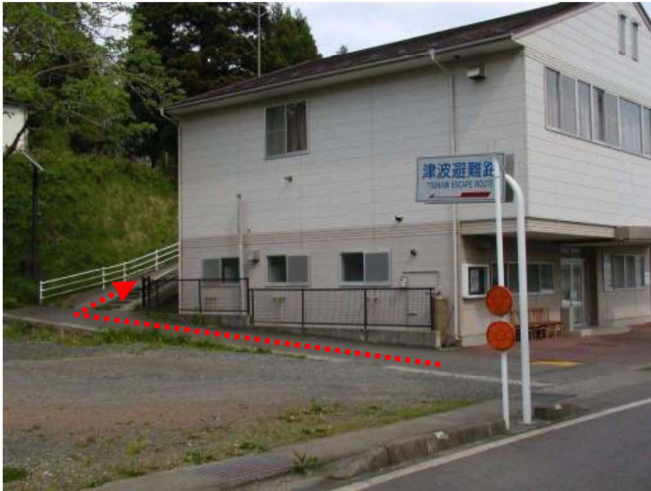
【写真 3-3-1 避難路・表示板整備状況】
