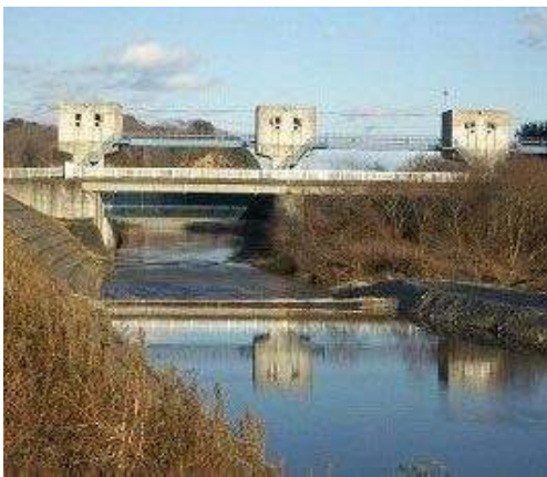
【写真 3-2-1 田代川水門】
