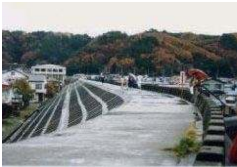
【写真 3-2-1 防潮堤整備状況】
