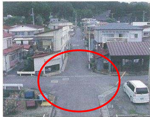
【写真 3-1-4 交差点隅切り状況】
