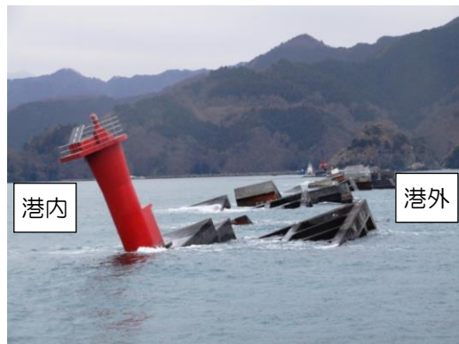
北堤の倒壊状況
