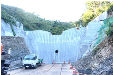
釜津田沢（災害関連緊急砂防事業）
