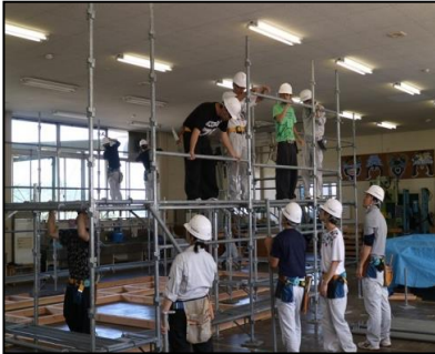
足場を組んで建方の勉強をします
