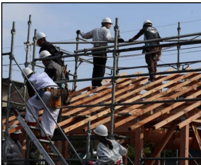
屋根に登っての高所作業も行います
