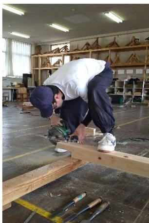
大まかな加工は工場の機械によって行われ、大工さんはそれを組み立てる、調整して仕上げていくという仕事がメインとなります。あらかじめ工場加工済みのものを現場で組み立てることによって、工期の短縮、建築現場の資材置き場や作業スペースの縮小、大工の技量によらない均質な加工などのメリットが得られるので、現在の木造住宅建築においてプレカットは幅広く用いられています。
