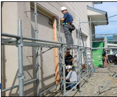
足場を組んで建方の勉強をします
