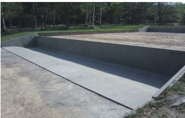
【後藤川温水路】対策工事後 すり減ったコンクリートをシートで補修
