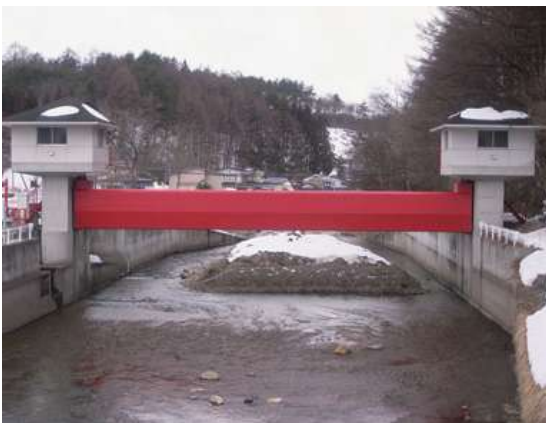
【瀬月内第一頭首工】対策工事後ゲートを再塗装（補修）
