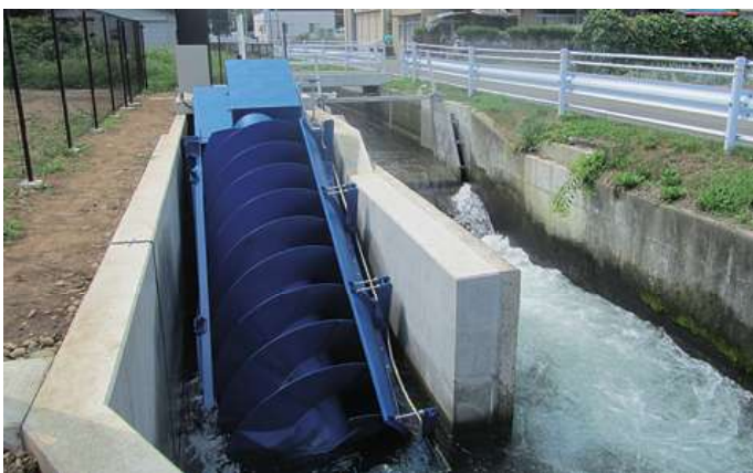
【荻野地区】小水力発電設備全景
