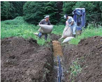
（写真：中山間地域等直接支払を活用して共同で暗渠を設置している様子）
