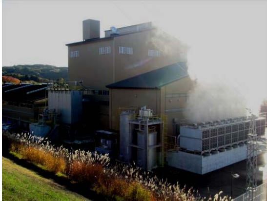
木質バイオマス発電施設
