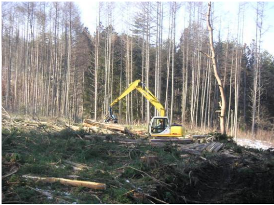
機械による地拵の状況
