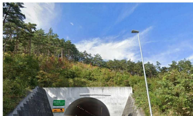
施工地の実施前の写真
