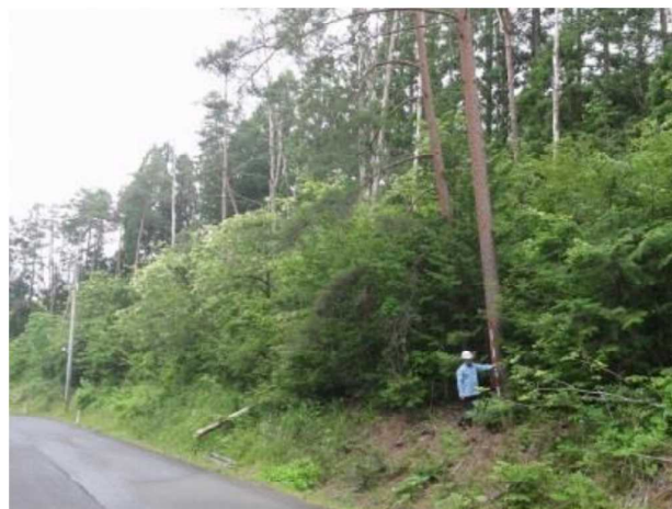
施工地の実施前の写真
