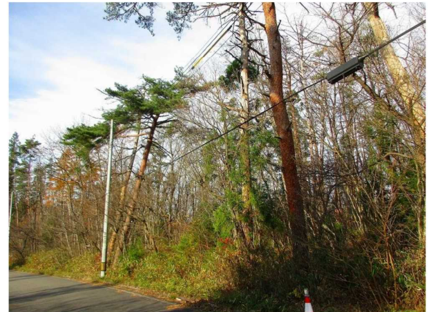
施工地の実施前の写真
