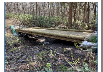
遊歩道整備（木橋）
