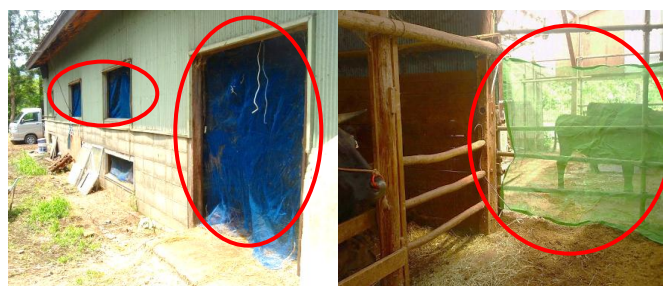
防虫ネットの設置 (出入口・窓)
