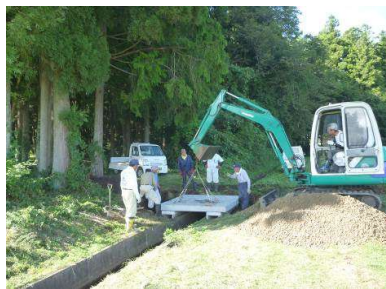
購入した機械による自己施工
