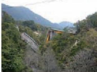
図2 2008年岩手宮城内陸地震における橋の崩落（推定震度6強以上）
