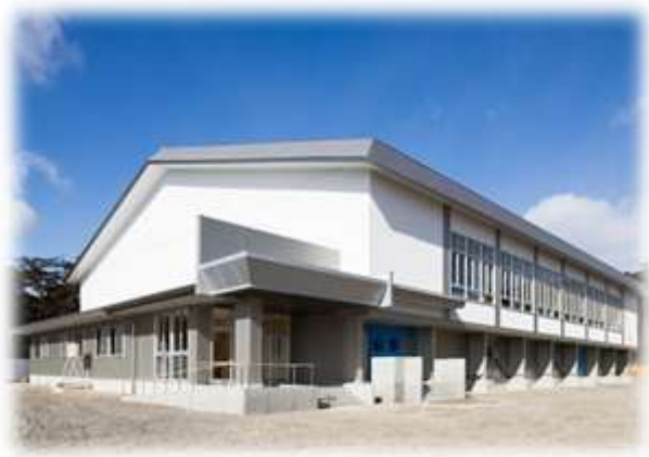
(体育館の外観)
