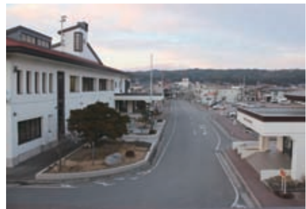
平成23年5月に工事着手、平成24年3月末に復旧した
