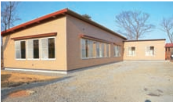
岩泉町立小本小学校仮設校舎〔木造〕 冬季の寒さ対策として、ペアガラスや断熱材で断熱性能を高めた。 (平成24年1月18日) 岩泉町教育委員会提供
