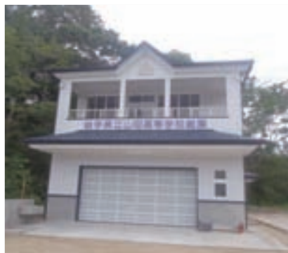
改修工事完了後の艇庫(平成24年7月3日)
