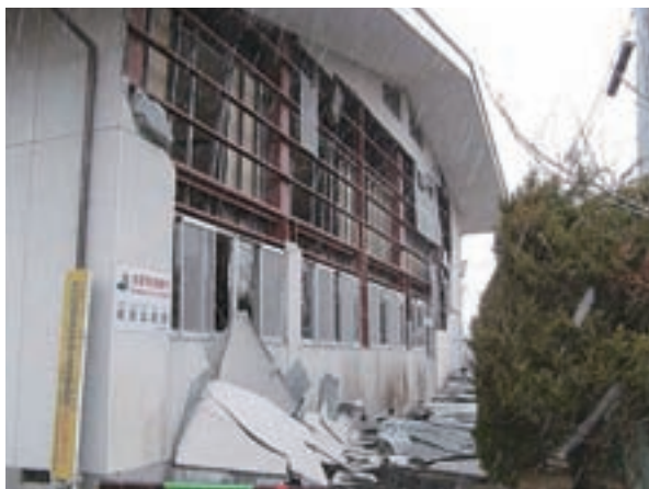
壁が落下した一関市立萩荘公民館(平成23年3月15日) 一関市教育委員会提供
