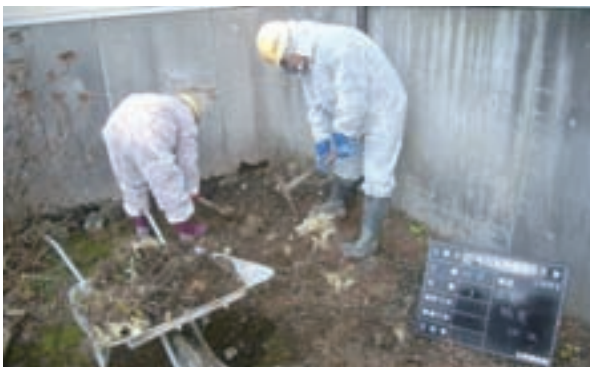
除染土壌を撤去する作業の様子
