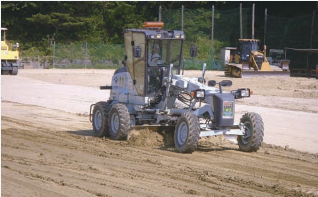
一関市立一関中学校の除染作業(平成24年8月22日)
