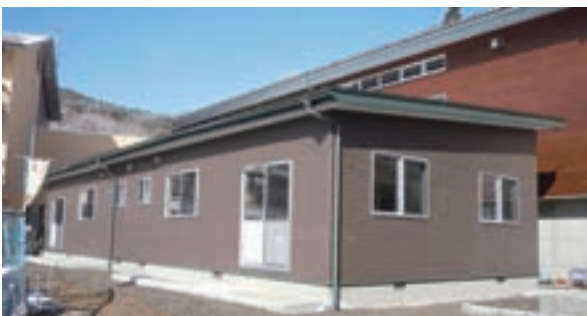
宮古市立鶏磯小学校・千鶏小学校共用の仮設職員室〔木造〕 夏場、冬場の快適性を考慮し、在来工法による木造平屋建てとした。限られた土地に仮設住宅等も建っているため風の通りが悪く、暑さ・湿気対策でエアコンを後付けした。 宮古市教育委員会提供
