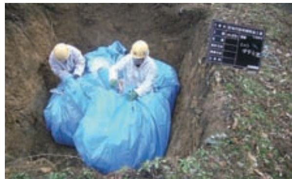
除去土壌を密閉保管する作業の様子
