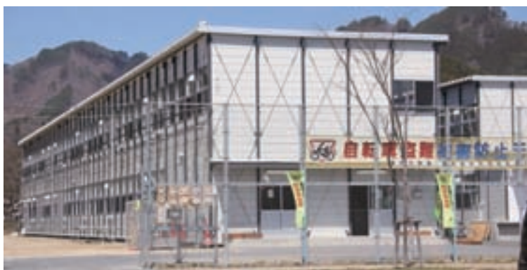
県内で最初に建設された大槌町の仮設校舎【鉄骨造】 写真は中学校棟 大槌町立大槌小、安渡小、赤浜小、大槌北小、大槌中の5校が使用する。(小学校4校は平成25年4月1日に学校統合)
