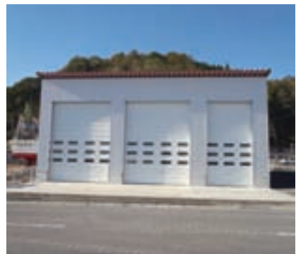
新築復旧した艇庫 (平成24年10月25日)
